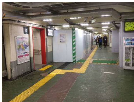
工事に着手した駒込駅東口のエレベーター
